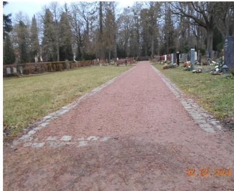
Alternative 1: Doppelte Läuferreihe aus gebrauchtem Granitkleinsteinpflaster in Beton versetzt in Grabfeld II.
