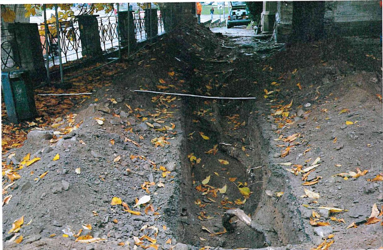
*Bild 5: Die Mitte des Suchgrabens liegt etwa 1,5 vom Stamm und 3,5 m von der Stützmauer entfernt*
