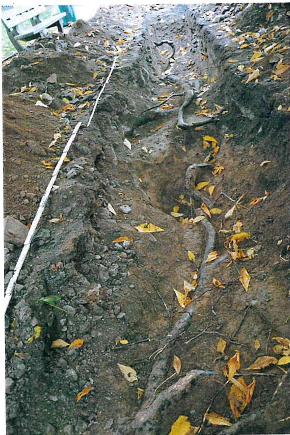
*Bild 7: Bei einer Abgrabung in der Mitte des Suchgrabens müssten die hier verlaufenden Starkwurzeln abgetrennt werden*
