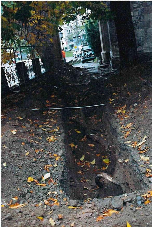
*Bild 4: Wurzelsuchgraben von Ost nach West, darin verlaufen vom Stamm aus mehrere sehr dicke Starkwurzeln in südlicher und östlicher Richtung*
