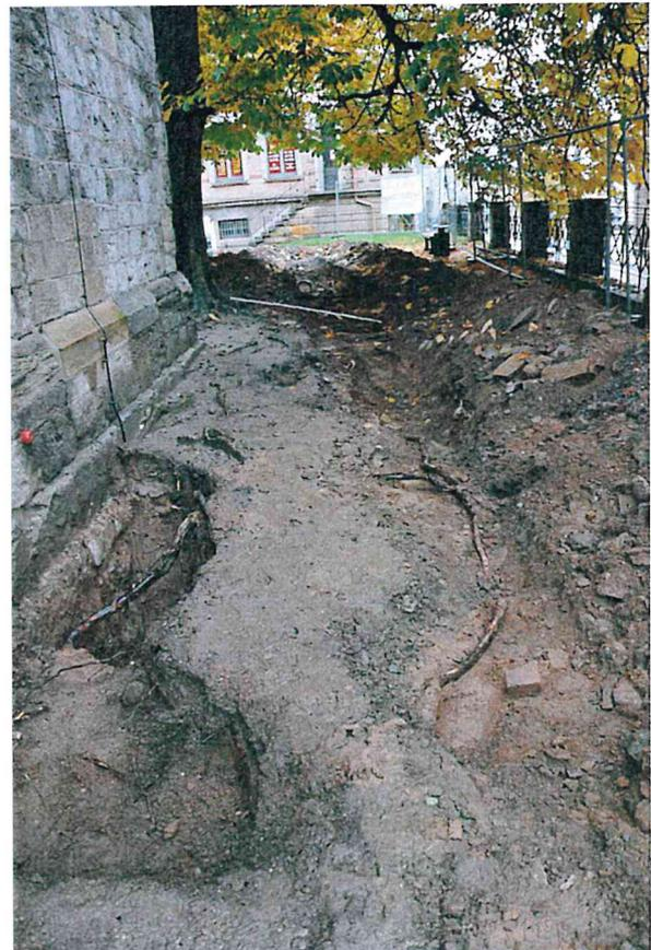
*Bild 3: Wurzelsuchgraben von West nach Ost, es verlaufen mehrere Starkwurzeln vom Stamm in westlicher Richtung; der Wurzelraum ist durch die angrenzenden Fundamente der Nikolaikirche eingeschränkt*
