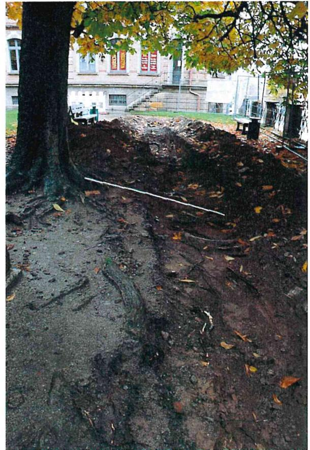
*Bild 6: Im Stammnahen Bereich verlaufen sehr viele Wurzeln in den Suchgraben und darüber hinaus, so dass bei einer Abgrabung ein gravierender Schaden entstände*
