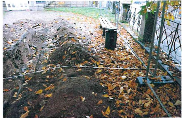
*Bild 8: Der Suchgraben bzw. die Böschungsoberkante des nötigen Arbeitsbereiches liegt etwa 3,5 m von der Stützmauer*
