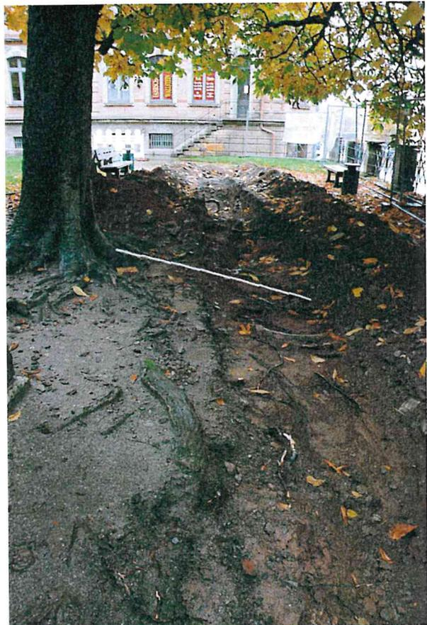
*Bild 6: Im Stammnahen Bereich verlaufen sehr viele Wurzeln in den Suchgraben und darüber hinaus, so dass bei einer Abgrabung ein gravierender Schaden entstände*
