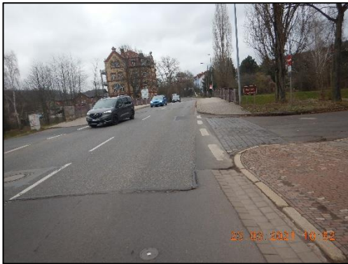
Blickrichtung: Westen (Standort östl. Hörsel)
