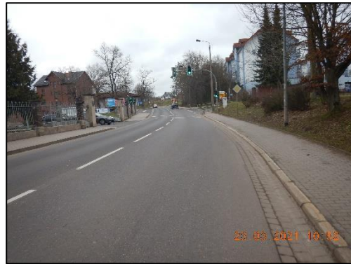
Blickrichtung: Westen (Standort östl. Hörsel)
