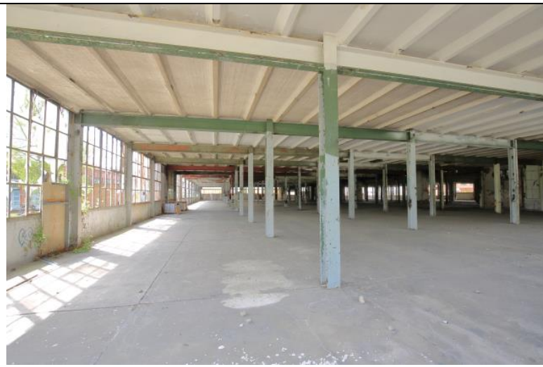
Abb. 6: Erdgeschoss, ehem. Fertigmacherei
