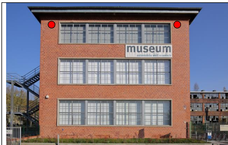
Abb. 26: Zwei Ersatzquartiere Museum Westfassade
