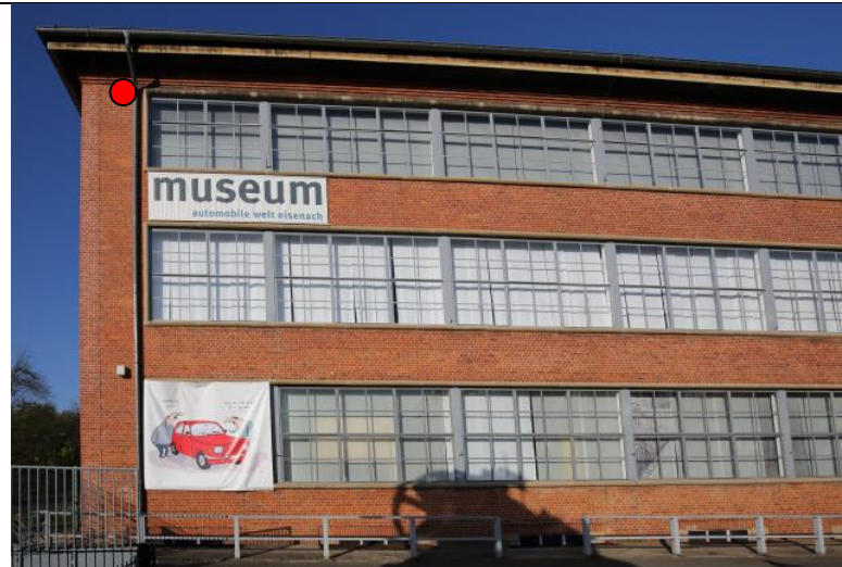
Abb. 27: Ein Ersatzquartier Museum Südfassade (Westseite)
