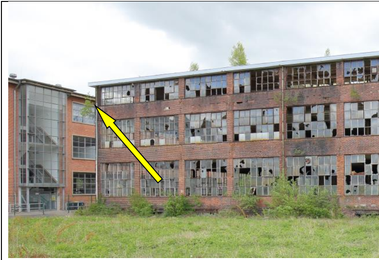
Abb. 16: Fledermausquartier Westfassade neben Fallrohr
