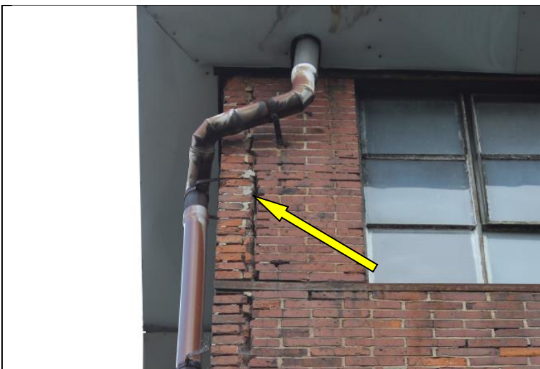
Abb. 18: Fledermausquartier Westfassade, Südseite
