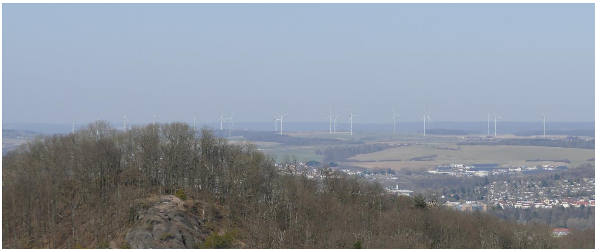
Abb. 9: Blick von der Wartburg, Zustand nach vollständiger Realisierung des Bebauungsplanes (Quelle: Visualisierung Eisenach Reitenberg, Ramboll Deutschland GmbH, Kassel)
