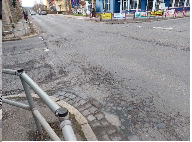
Rennbahn, Anschluss Hospitalstraße
