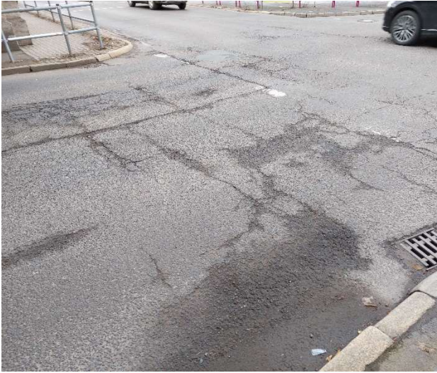
Hospitalstraße Fahrbahn, Anschluss Rennbahn
