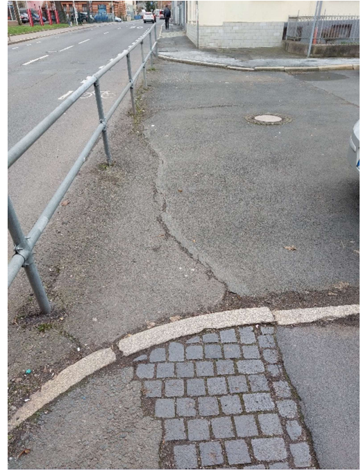
Anschluss westliche Werneburgstraße, Herstellung Gehweg
