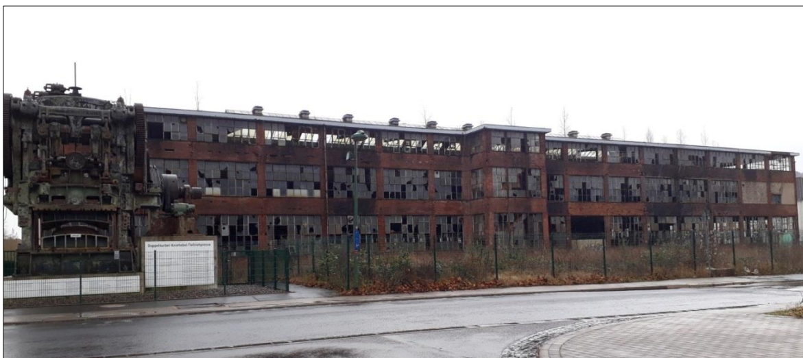
Werksgebäude O1, Straßenansicht Friedrich-Naumann-Straße
