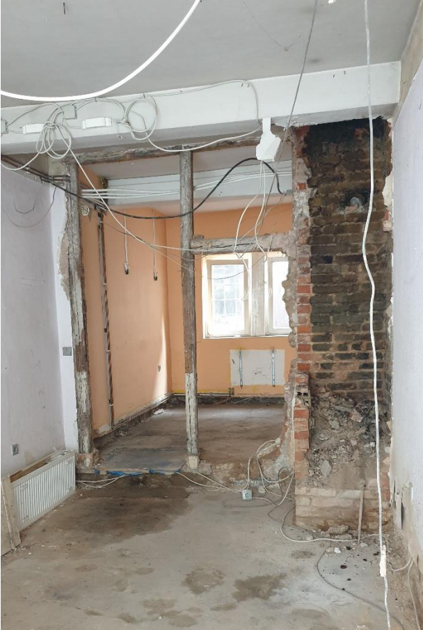
Abbildung 1: Löberstraße 9 vor Umbaubonus
