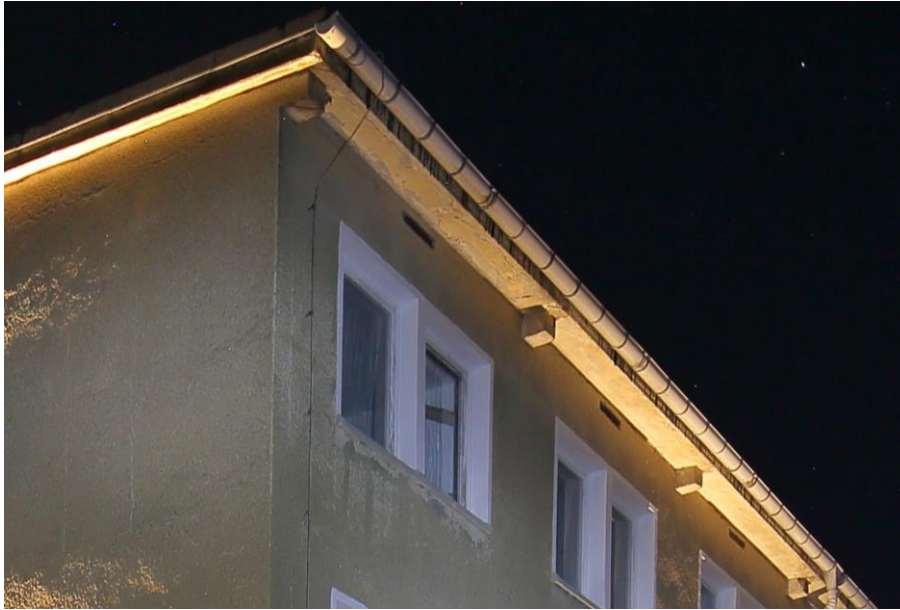
Abb. 26: Lüftungsöffnungen am Gebäude 8
