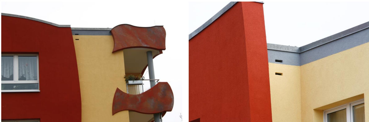
Beispiel für Fledermauseinbausteine in die Außendämmung
