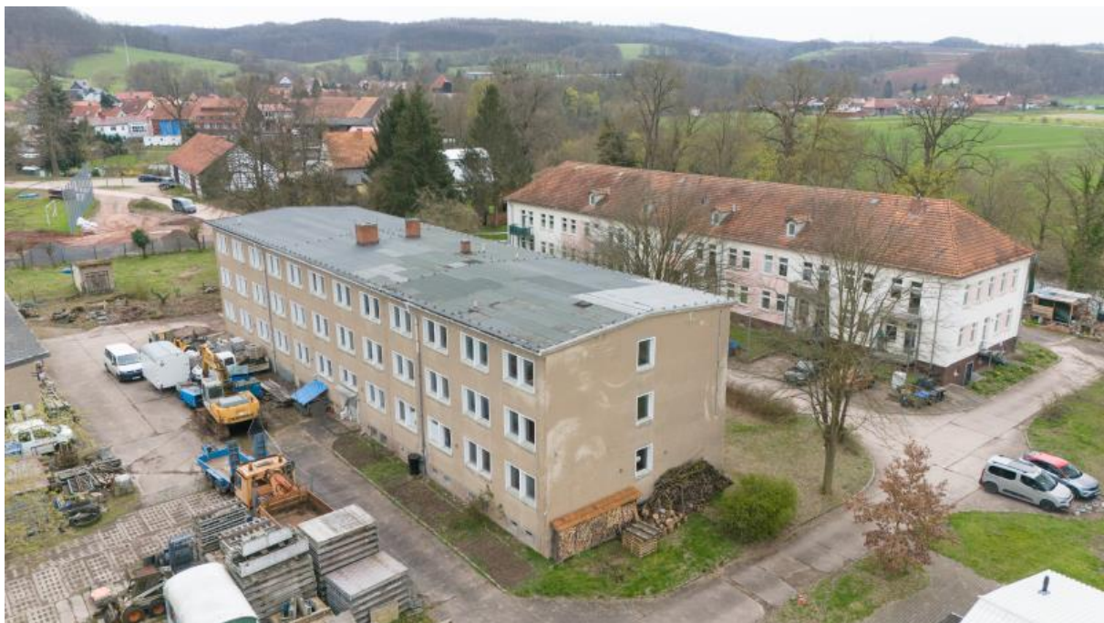
Gebäude Nr. 8 (links) und Nr. 3-5 (rechts)
