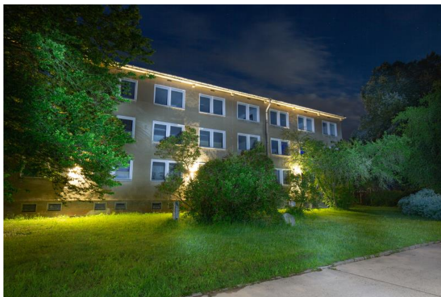
Abb. 7: Gebäude Nr. 8. Westfassade
