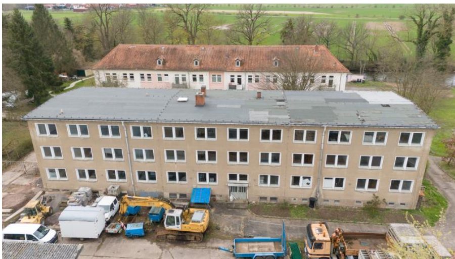
Abb. 2: Ostansichten des Gebäudes Nr. 8
