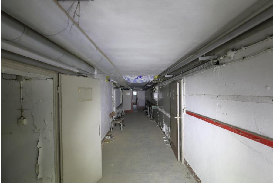
Abb. 10: Blick in das Kellergeschoss
