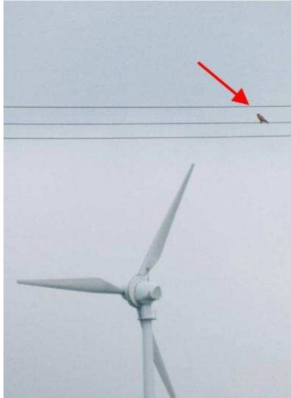
Foto 10 Turmfalke auf der 20 kV-Freileitung (Foto: Bernd von Eschwege; Mai 2010)
