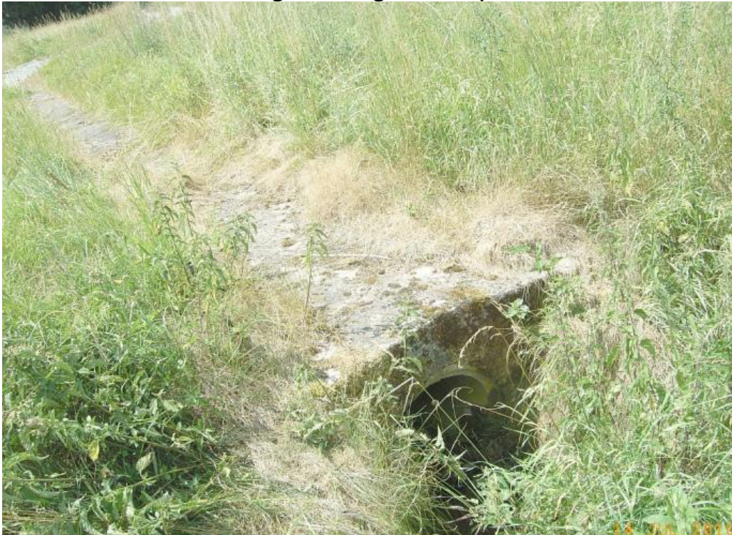
Foto 6 Bachverrohrung am Nordrand des Plangebietes an der Schotterwegkreuzung (Foto B. Möller, Juli 2010)
