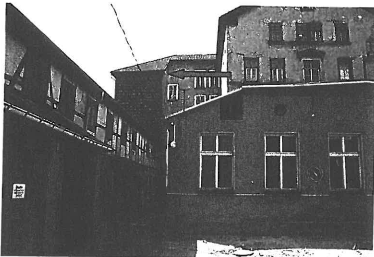
Abb. 7: Brutplatz der Turmfalken Die Vögel nisten seit Jahren im Dachkasten.
