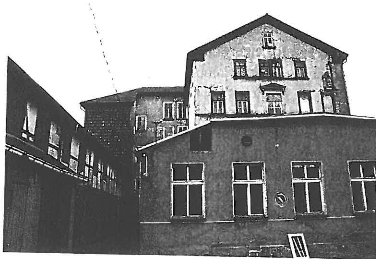
Abb. 2: Gebäude Bahnhofstr. 38 Rechtwinkliges Hauptgebäude mit Saalanbau im Vordergrund sowie Wohn- und Wirt- schaftsgebäude, links.
