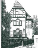
Bild 2: Luisenstraße Nr. 16 im Bestand 3-geschosig
