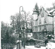
Bild 4: Waisenstraße Nr. 1 die direkte Nachbarbebauung weist eine 3 Geschosigkeit auf
