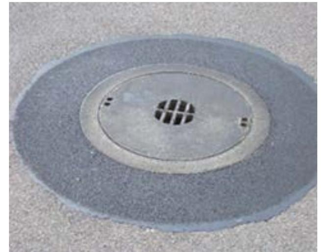
Bsp.: Schachtabdeckung mit Gussasphalt, Ottendorf-Okrilla
