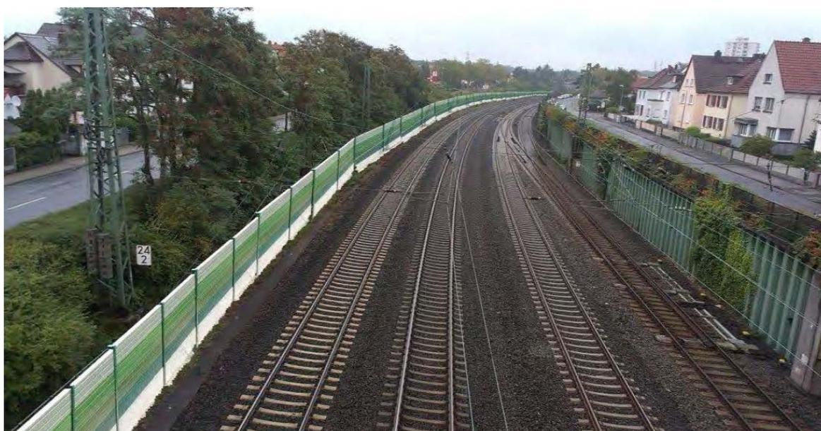
Foto: Beispiel für Lärmschutz entlang einer Haupteisenbahnstrecke
