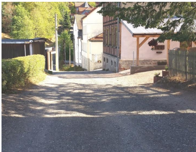
Erneuerung Verkehrsflächen Wolfgang, oberer Abschnitt
