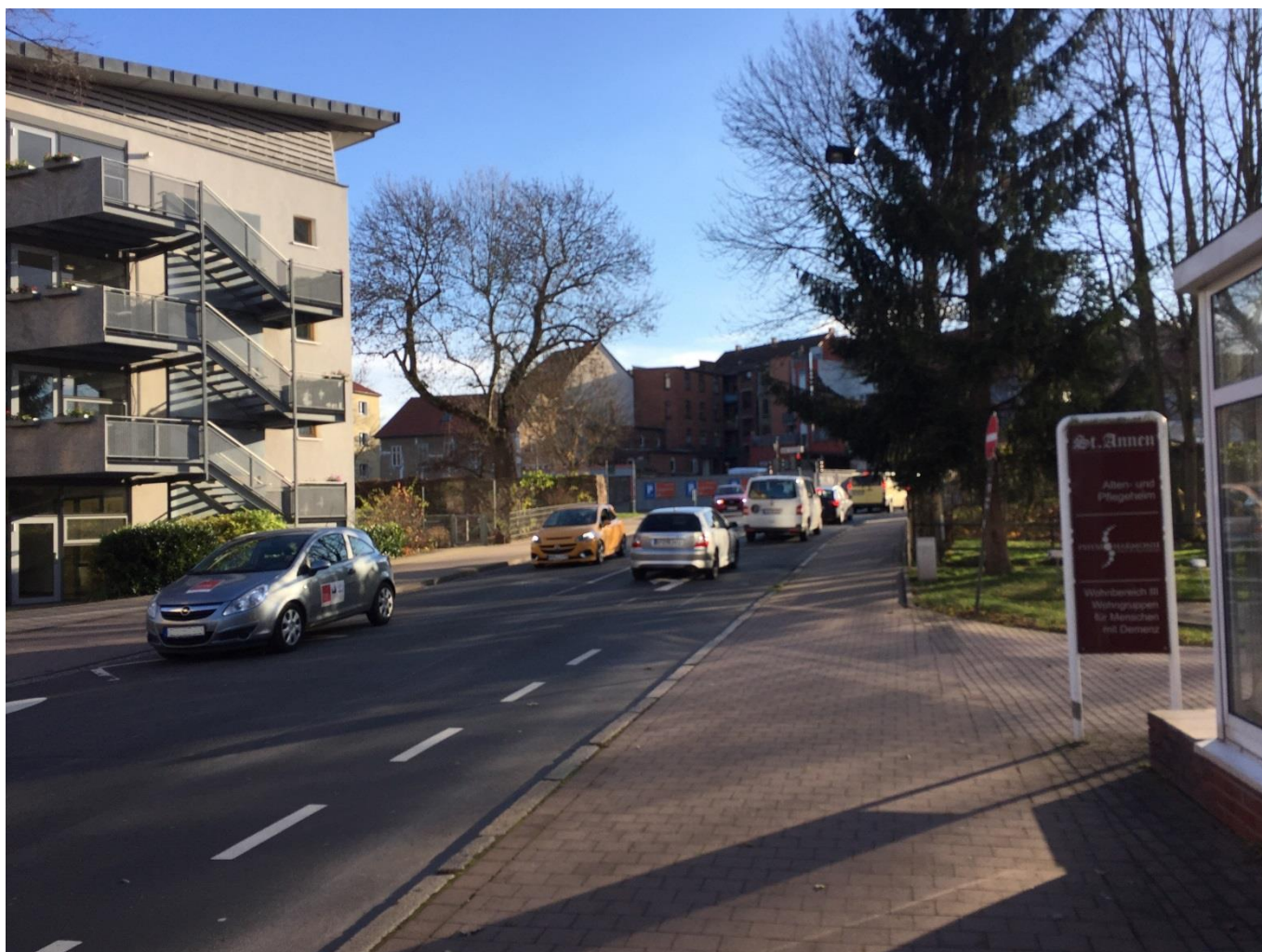
Erneuerung Hospitalstraße nördlicher Abschnitt
