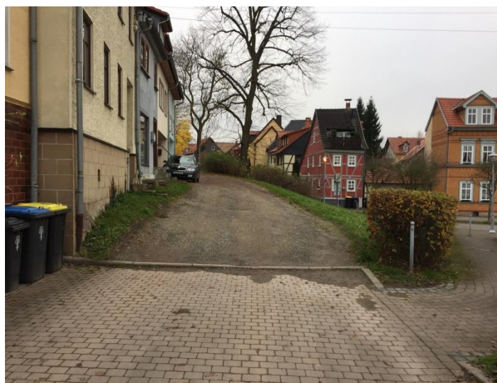
Erneuerung Ehrenstieg Teilbereich
