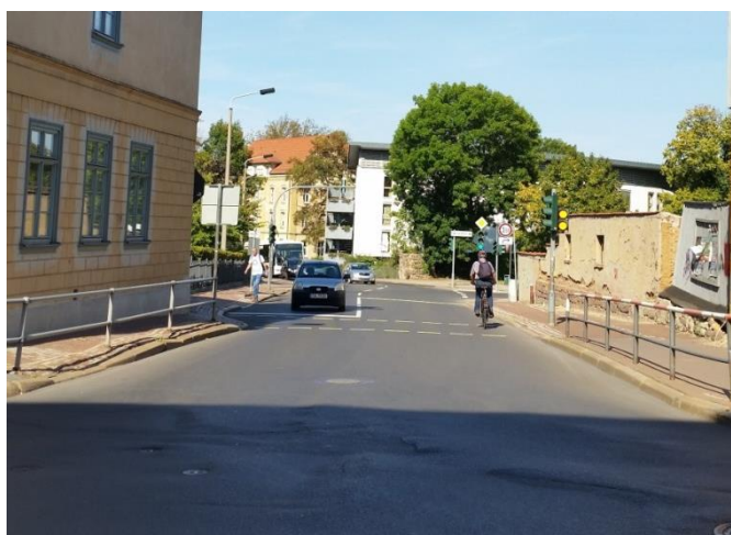
Erneuern Verkehrsflächen Hospitalstraße
