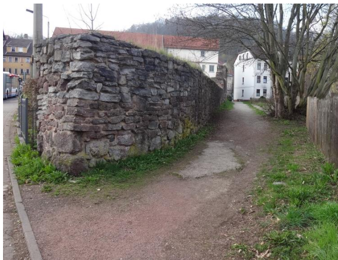
Erneuerung des Weges entlang der Stadtmauer
