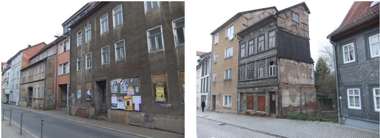
Abbildung 42 / 43 Gebäudeleerstand in der Alexanderstraße sowie Leerstand und Baulücke in der Lutherstraße
