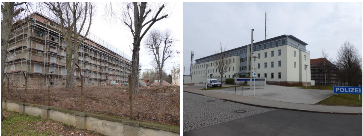
Abbildung 75 / 76 Sanierung der ehem. Kasernengebäude im Jahr 2017 (links) und erfolgreiche Umnutzung als Polizeipräsidium (rechts)
