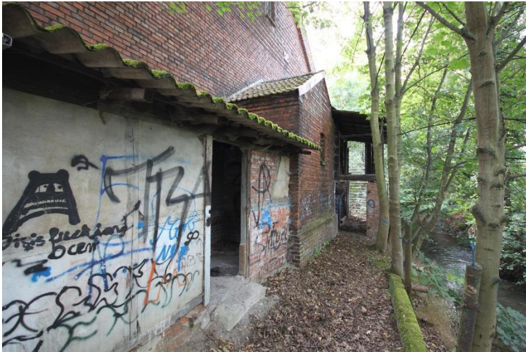
Teilansicht der Nordfassade von der Bestands-Sporthalle, rechts im Bild der Mühlgraben
