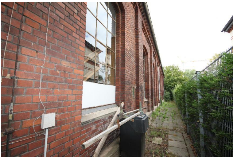
Blick auf die Ostfassade der Bestands-Sporthalle
