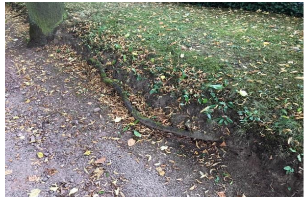
ausgespülter Weg mit freigelegter Baumwurzel
