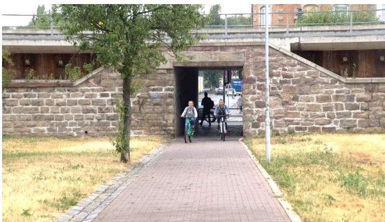
Foto: Gehweg südlich des Bahndurchgangs Wilhelm-Rinkens-Straße an dem sich eine Sitzbank als Ruhemöglichkeit anbieten würde
