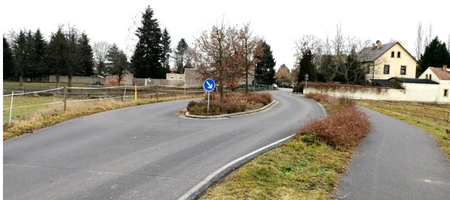
Foto: Beispiel für eine Fahrbahnaufweitung im Ortseingangsbereich
