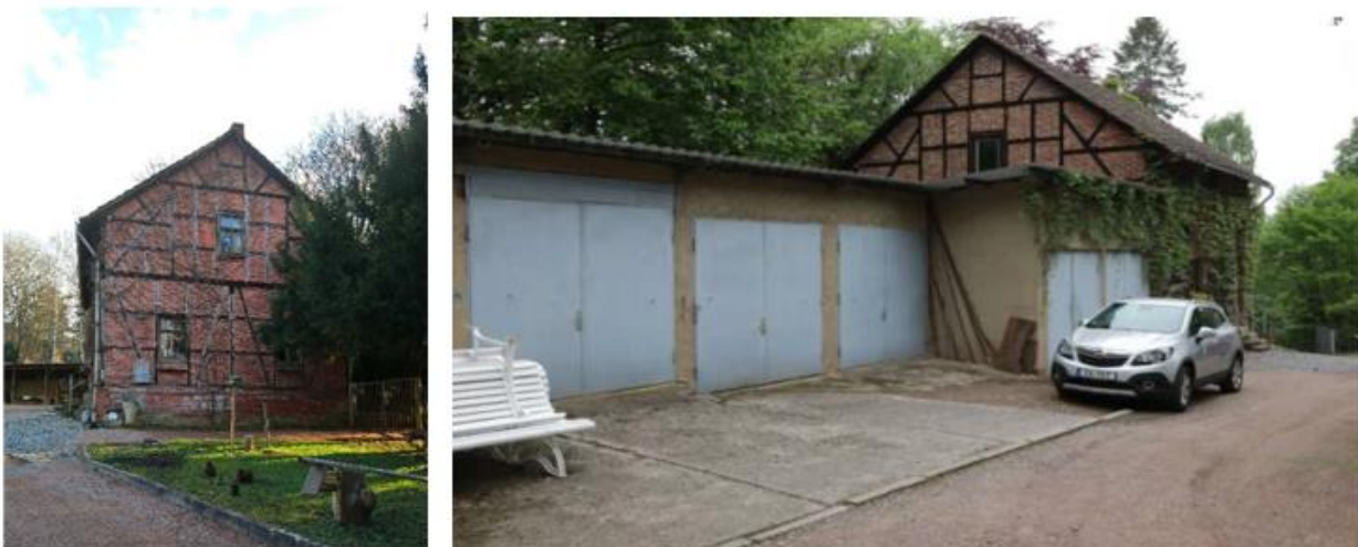
Abbildung 5: Mitarbeitergebäude und Garagen (eigene Fotos)
