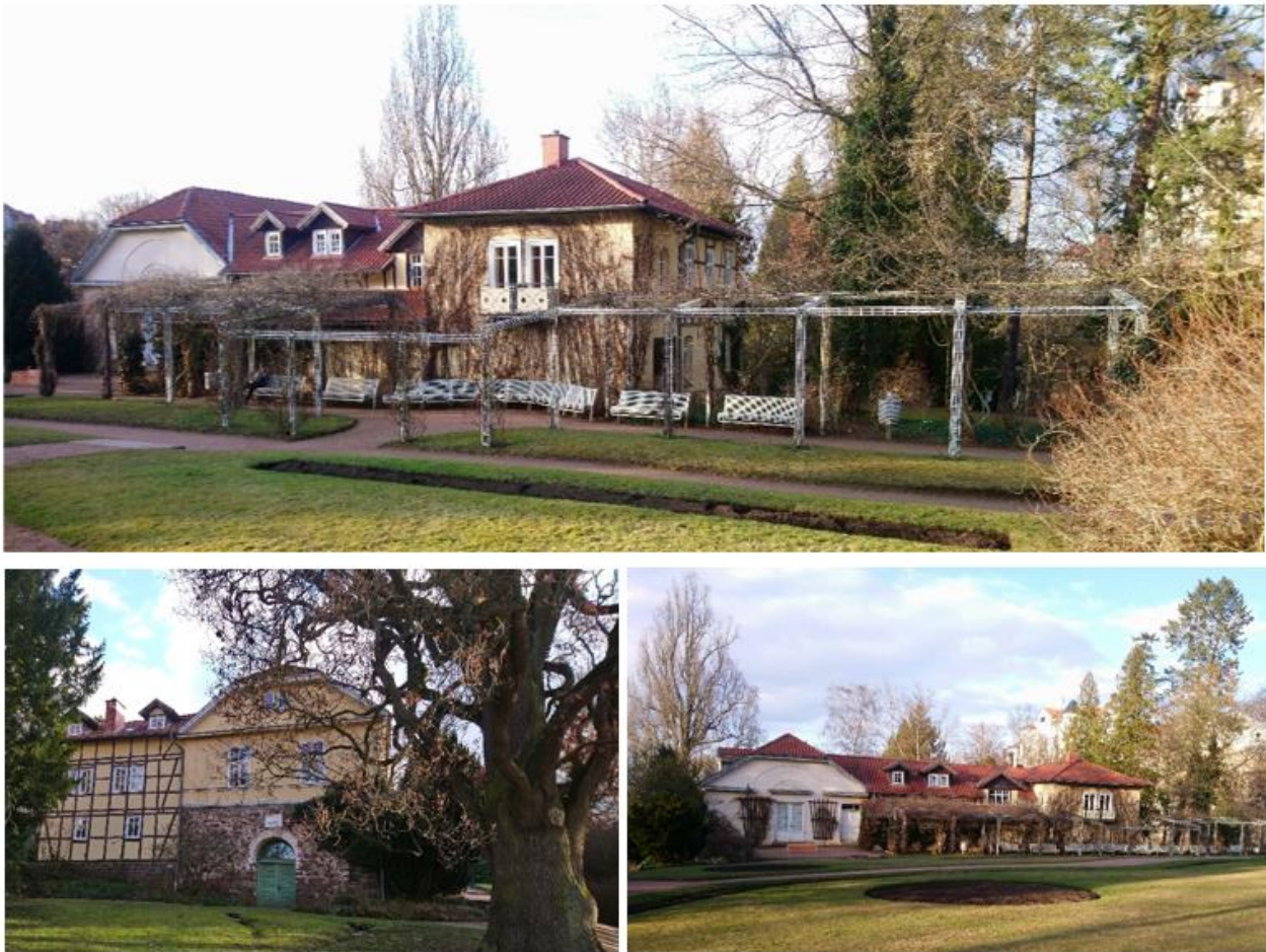
Abbildung 2: Gärtnerhaus Außenansichten (eigene Fotos)
