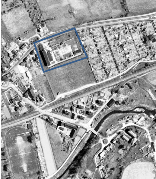
Abb. 6: 1980-05-13_0251* Umspannstation auf Flurstück vorhanden
