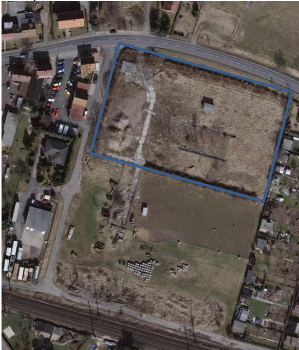
Abb. 8: 2012-03-17_0149* Umspannstation bereits rückgebaut, aber Fundamente noch vorhanden, südl. ans FISt. angrenzender Teil ist Brache
