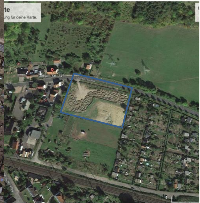
Abb. 9: 2013 (Quelle Google Earth) Rückbau Fundamente erfolgt, Bauschutt- haufwerke sichtbar (werden später 2014 noch entsorgt), südl. Teil ist Brache / Wiese
