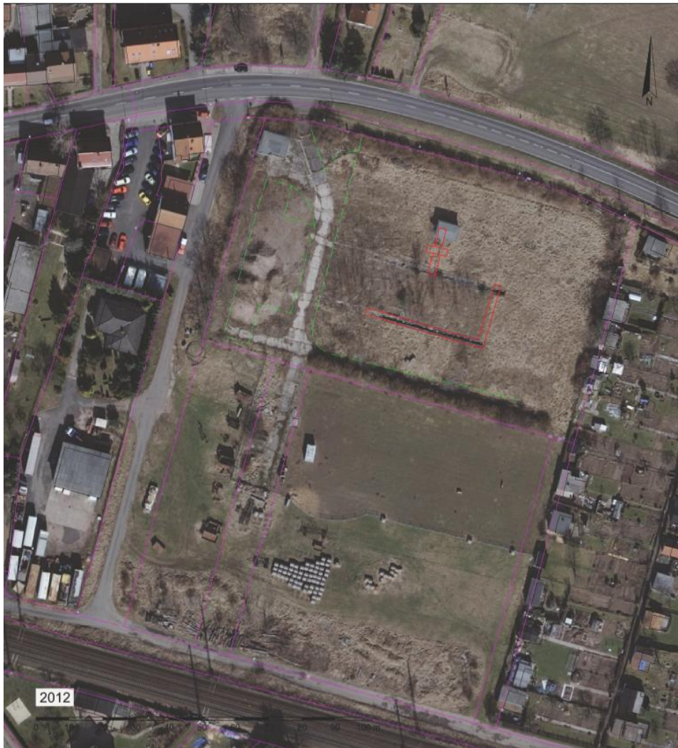
Abb. 16: analog Abb. 14 aber auf LB 2012 nach Abriss der Anlage und Bausubstanz, aber mit noch vorhandenen Fundamenten
