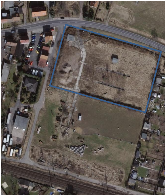
Abb. 8: 2012-03-17_0149* Umspannstation bereits rückgebaut, aber Fundamente noch vorhanden, südl. ans F1St. angrenzender Teil ist Brache
