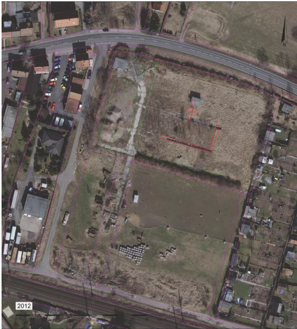
Abb. 16: analog Abb. 14 aber auf LB 2012 nach Abriss der Anlage und Bausubstanz, aber mit noch vorhandenen Fundamenten
