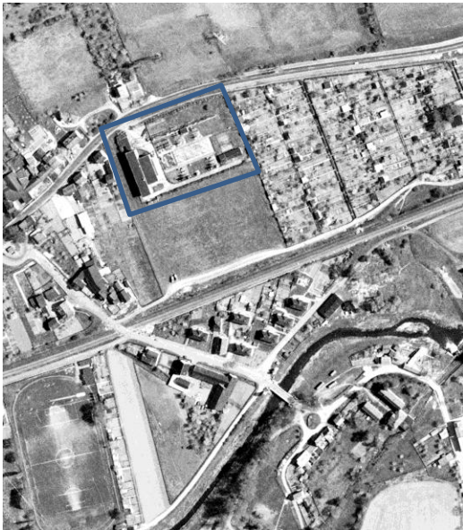
Abb. 6: 1980-05-13_0251* Umspannstation auf Flurstück vorhanden
