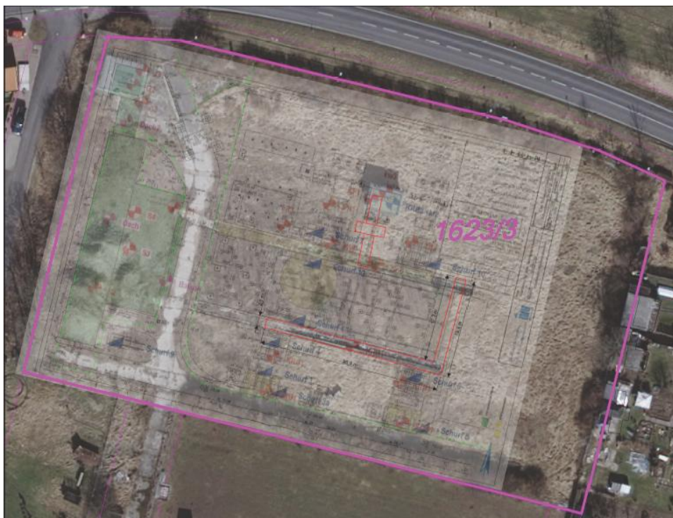
Abb. 17: Skizze der Schürfe der Voruntersuchun- gen 2007 (siehe Abb. 12) und der Schürfe und Sanierungs-/ Aushubbereiche des kontaminierten Bodens auf LB 2012 mit noch komplett vorhandener Anlage und Bausubstanz
