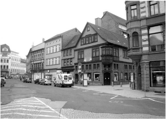
2006 – Bislang ist der Platz vor der Stadtpotheke ein Flickenteppich aus verschiedenen Materialien und Reparaturspuren, auf dem Fahrzeuge in alle möglichen Richtungen verkehren. Als Fußgänger ist der Platz hier nur mühsam zu queren.
