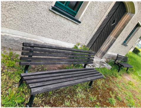
mit Unkraut überwuchertes Eingang vor der Leichenhalle, Bänke marode
